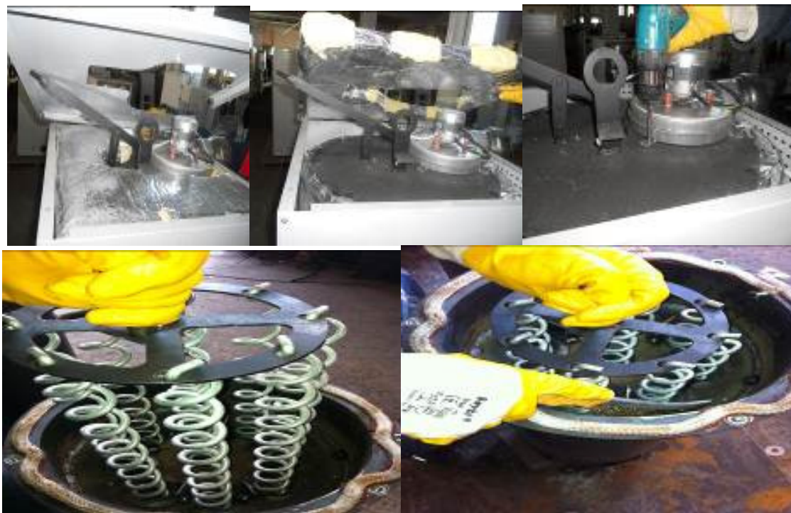
Καθαρισμός ανεμιστήρα και σωλήνα καυσαερίων
